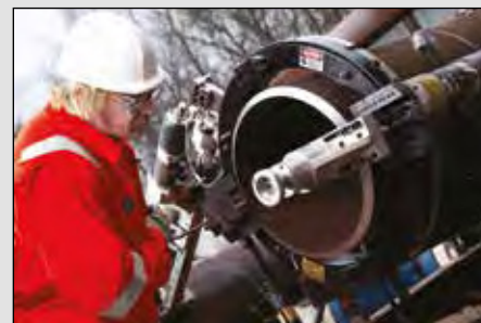
▲ Cortadoras de tubo y preparación de soldadura.
