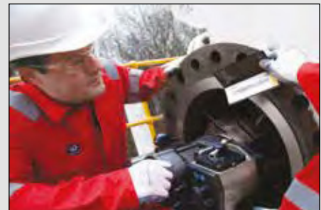
▲ Rectificadoras de bridas para asegurar la integridad de la junta embridada.
