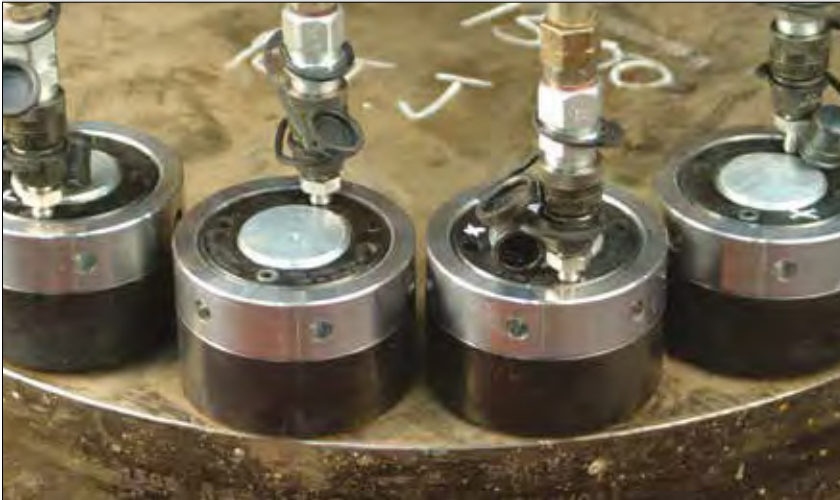
▲ Tensionado con tuercas hidráulicas.
